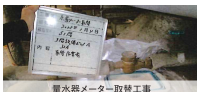
量水器メーター取替工事
