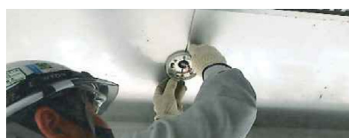
1階プラザ炎感知器取替工事
