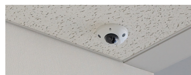
ビジネスセンター監視カメラ設置
