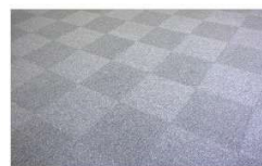
再生タイルカーペットの導入
