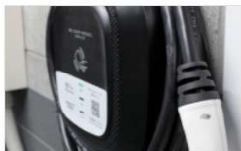
EV充電器の設置
