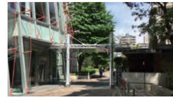
リーガロイヤルホテルへの連絡通路 Entrance to the Rihga Royal Hotel
