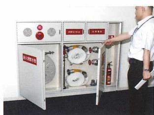
各フロアには屋内消火栓が設置され、高層階(11・12F)には消防隊専用の放水口・ホースがあります。
