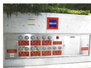
建物の北東側・北西側・南東側の3カ所に消防隊専用の送水口等が設置されています。
